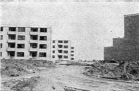
Bild 2 (großes Hochhaus im Bau) „Die leeren Fenster sind so dunkel und erinnern mich an das Böse. Mich erinnert das Bild daran, daß Gott die Welt gemacht hat, und daß wir Menschen weiterbauen sollen. Ob mit dem Anfang einer neuen Stadt auch neues Glück für die Menschen verbunden ist?“
